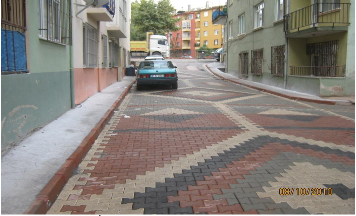
İsmailağa zakkum sokak kaldırım yapımı
