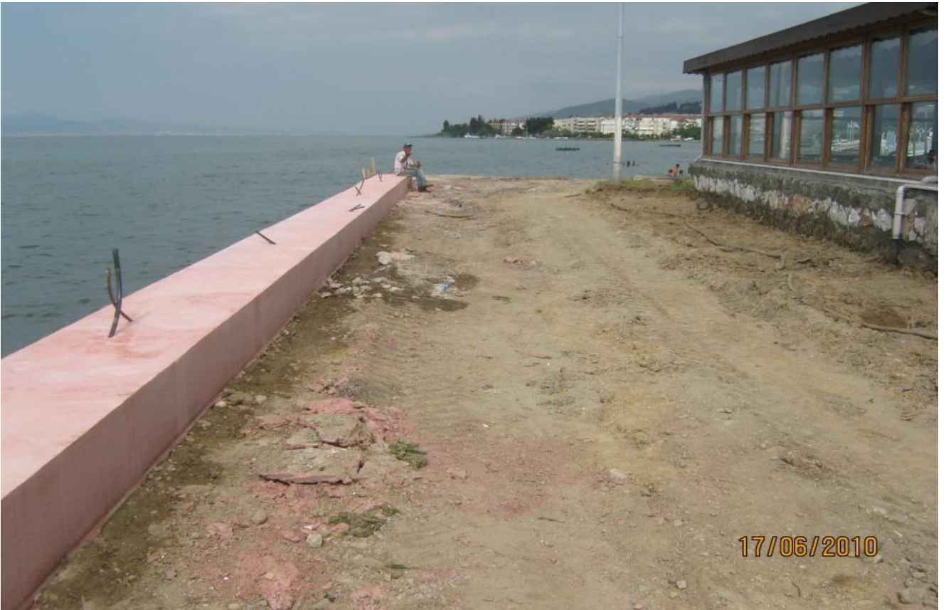
Sahil bandı rıhtım yapımı
