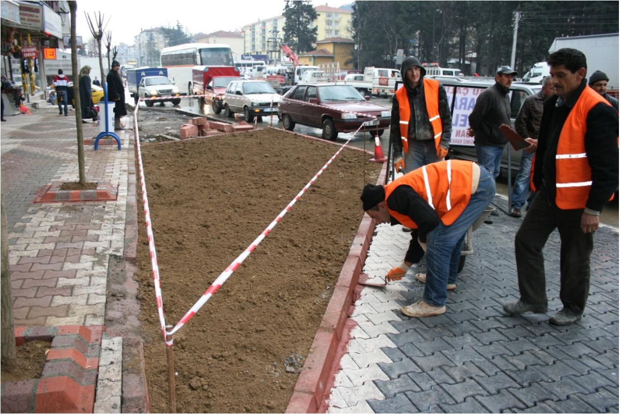
D-130 Karayolu yan yol çalışması.
