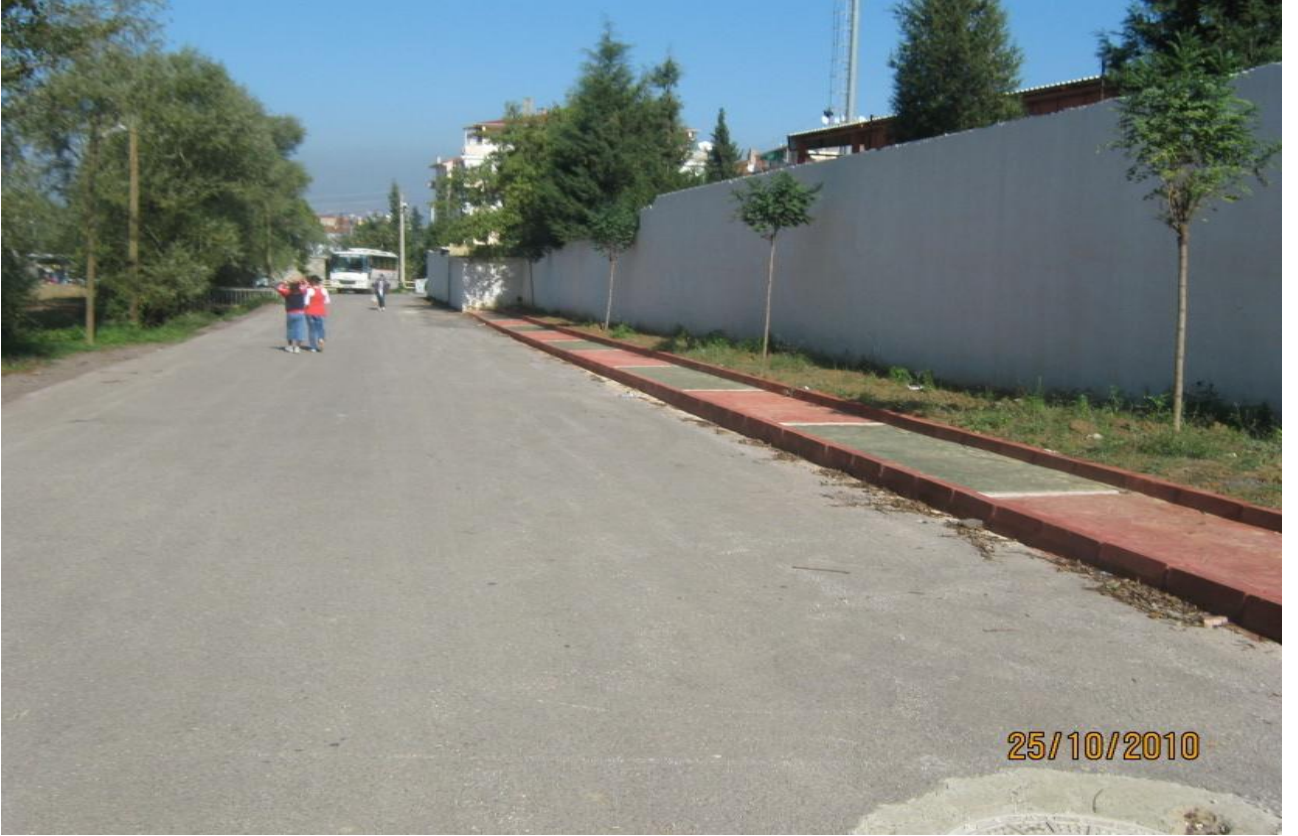
Stad yanı dere kenarı kaldırım yapımı
