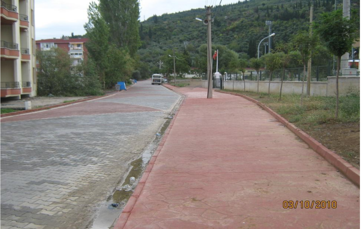
115. Cad.Stad altı kaldırım yapımı
