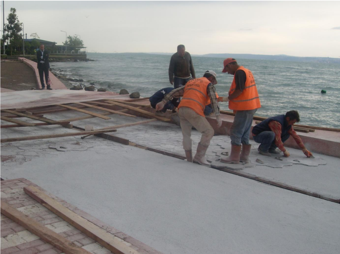
Sahil yolu baskılı beton çalışması
