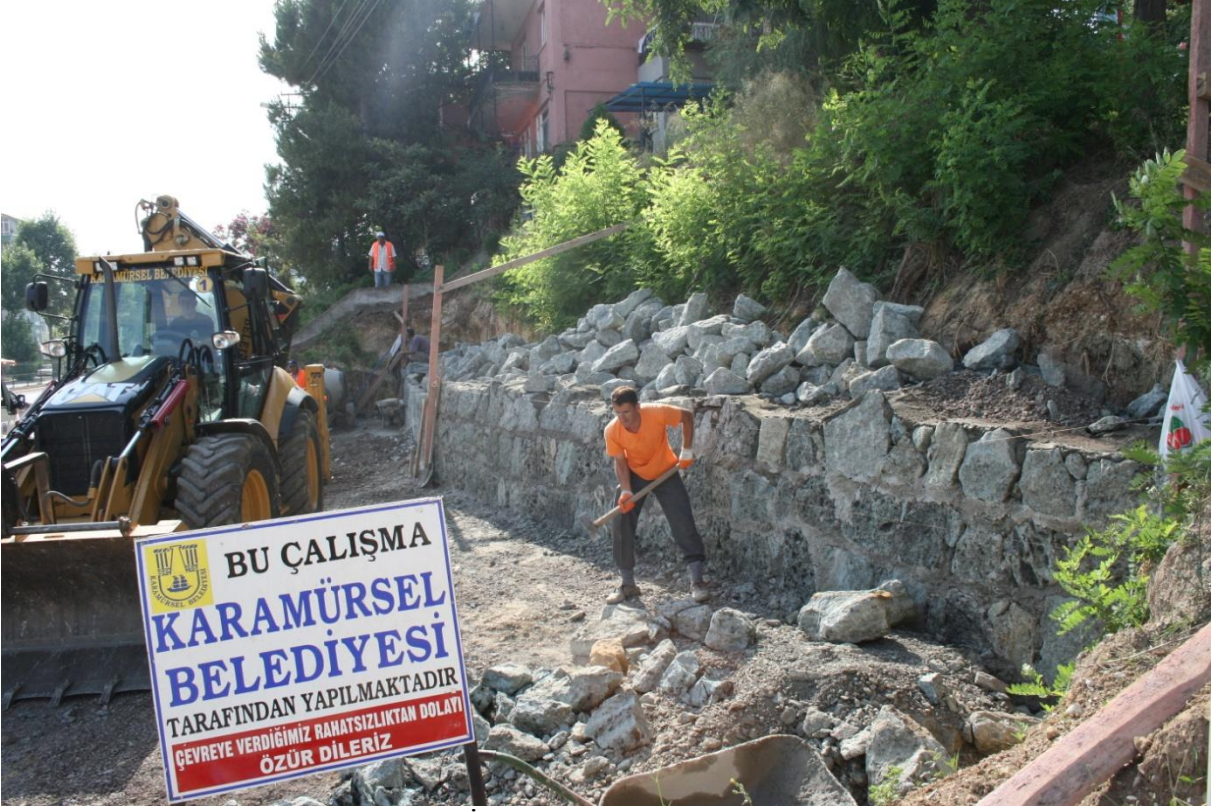
D-130 karayolu İznik yolu girişi istinat duvarı yapımı
