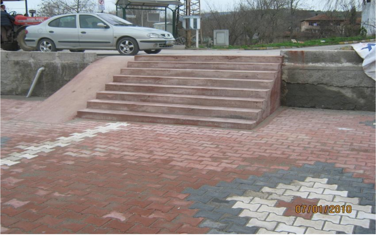
Yalakdere beton yapımı
