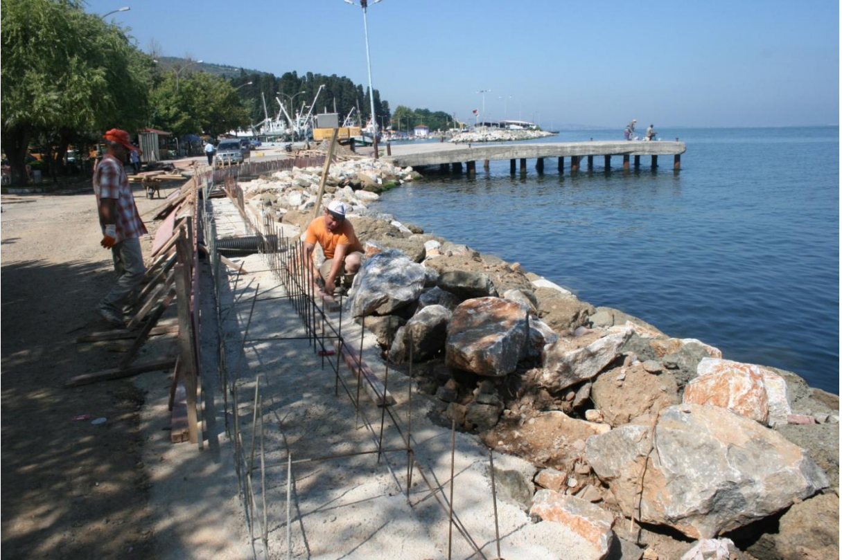
Ereğli sahil yolu ve rıhtım çalışmaları
