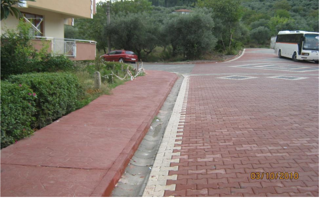
115. Cad.Stad altın kaldırım yapımı
