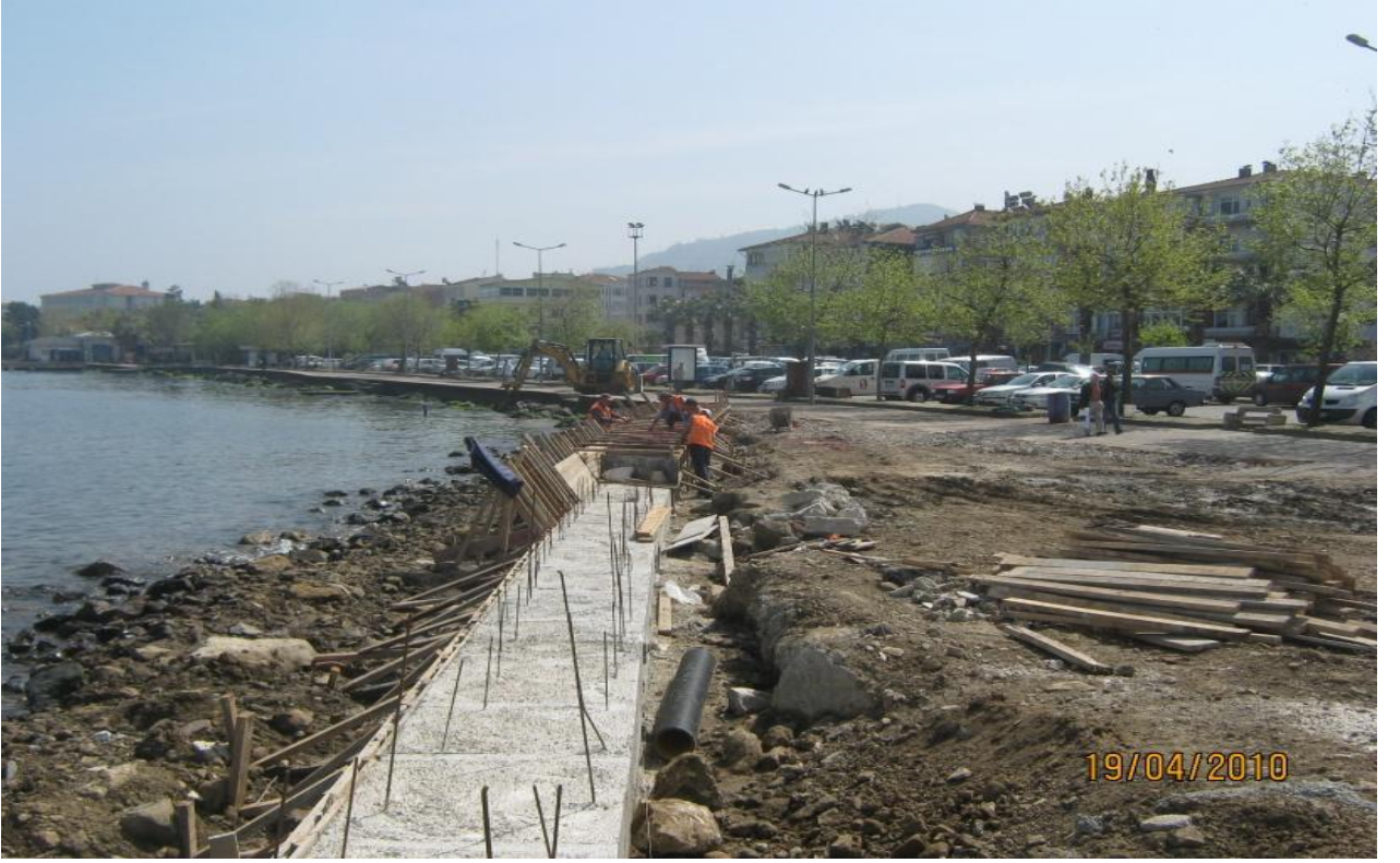
Balık adası rıhtım yapımı
